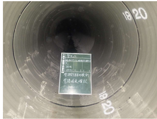
Φ1200管渠内部状況
