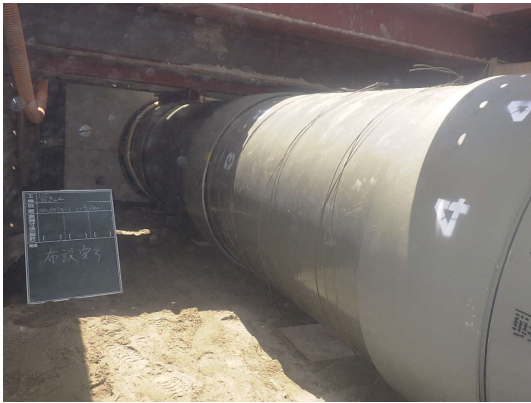
Φ1200管渠布設完了
