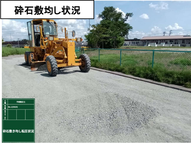
砕石敷均し状況
