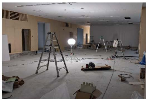
1階「執務室」(R2.12.24 撮影) 内装仕上げ工事をしています
