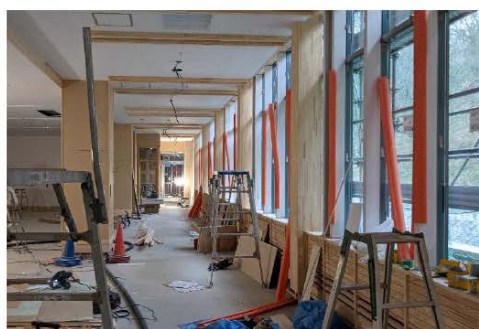
1階「待合ホール」(R2.12.24 撮影) 内装仕上げ工事をしています
