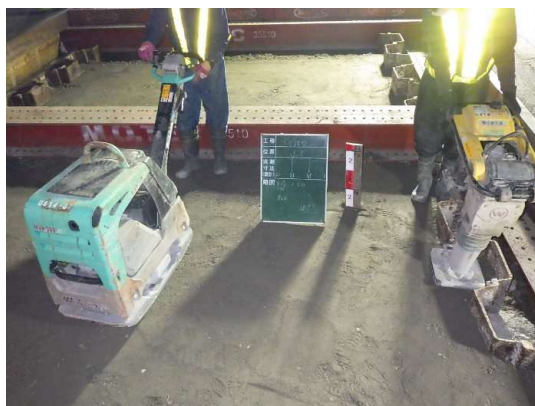
埋戻し転圧状況
