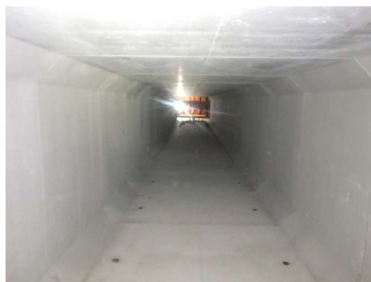
ボックスカルバート布設完了
