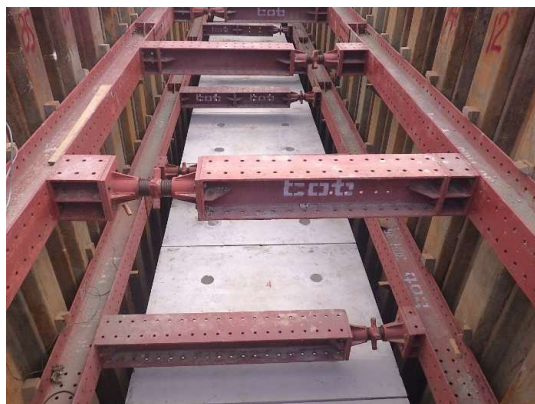
ボックスカルバート布設状況
