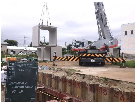
ボックスカルバート布設状況
