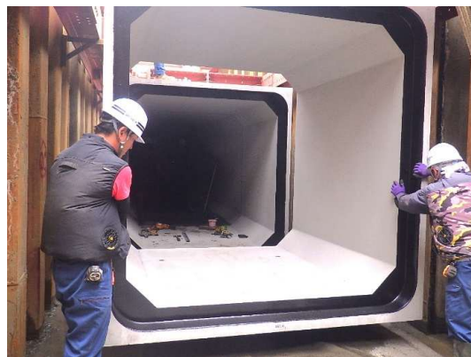
ボックスカルバート布設状況
