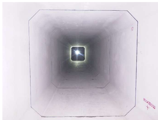
ボックスカルバート布設完了
