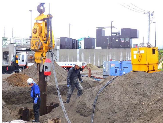
合流樋：鋼矢板撤去状況
