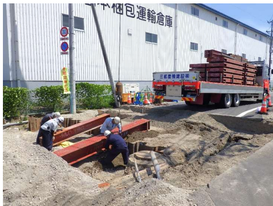
合流樋：覆工板撤去状況
