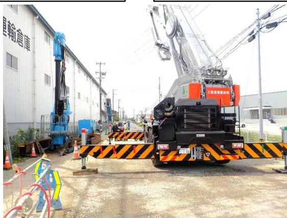
流入水路：鋼矢板打込み状況
