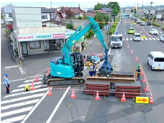
割込立坑：掘削状況
