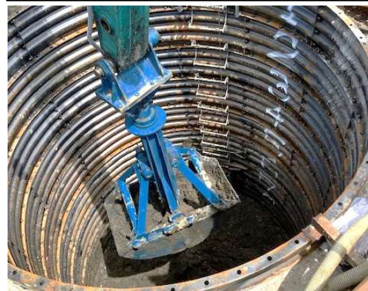
割込立坑：ライナープレート設置、掘削状況
