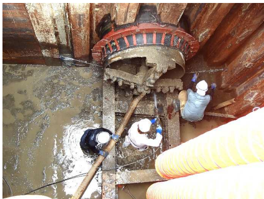
到達立坑：推進機到達状況
