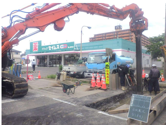
親杭(H鋼)引抜き状況
