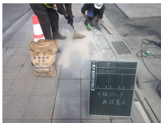
平板ブロック再設置状況
