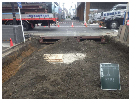
覆工板撤去状況
