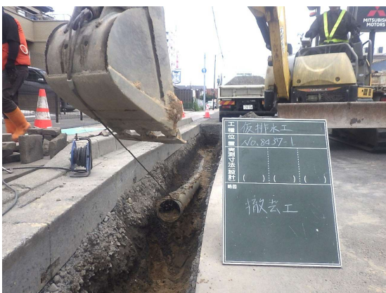
仮排水管撤去状況
