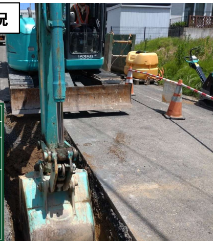
土留設置状況
