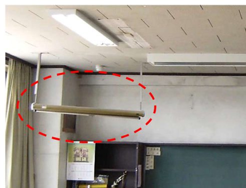
E 6-2 天井面重量物の落下の危険を確認
