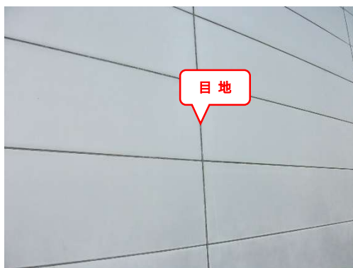
C 4-1 外壁目地シーリングの亀裂、硬化
