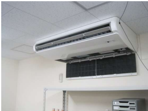
H 1-1 エアコン室内機フィルターのホコリたまりの確認
