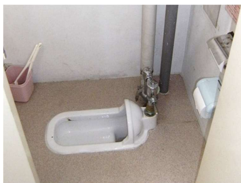
F 1-1 便器の破損、水漏れ等の確認
