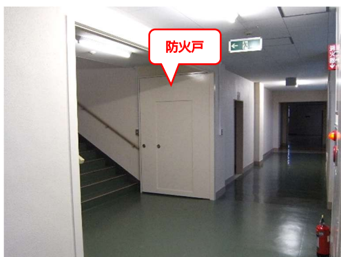
E 7 避難経路の障害物の確認
