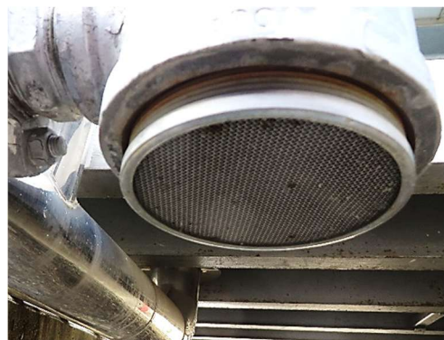
F 5-4 防虫網の破損の確認 (左記写真オーバーフロー管の下部)
