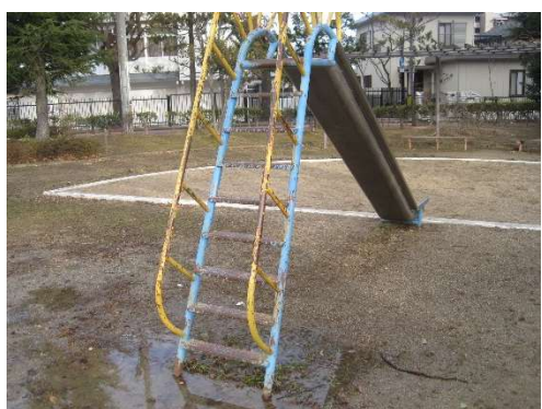
A 5-2 遊具の腐食、ぐらつきの確認
