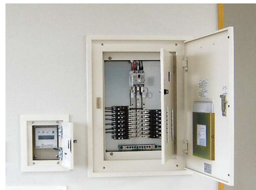
K 2 分電盤の異音、異臭、開閉・施錠不良の確認
