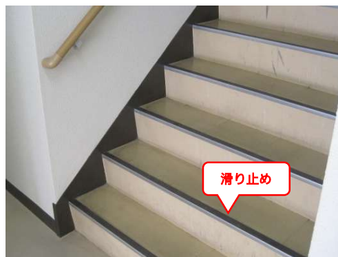
E 5-2 階段滑り止めの破損や剥がれの確認
