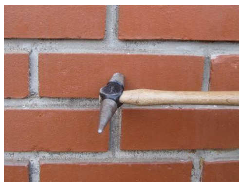
C 2-4 ハンマーで軽くたたいて浮きを確認 (音の違いを確認)
