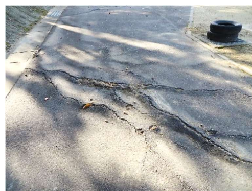
A 3-1 アスファルトの大きなひび割れ
