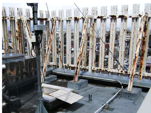
B 4 屋上フェンスの腐食 (特に支柱の根元の腐食に注意)
