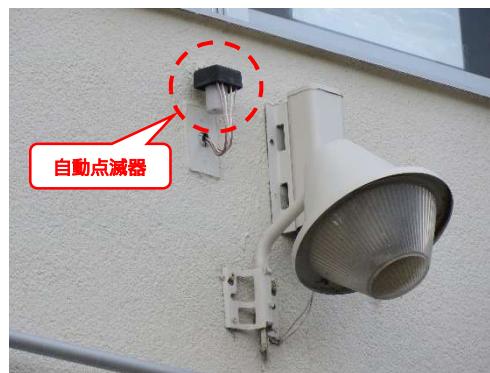
I 3-3 外壁に設置した自動点滅器の例
