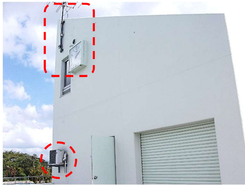
C 5-3 壁面設置物の落下の危険を確認 (手が届く箇所はゆすって、高所は目視で確認)
