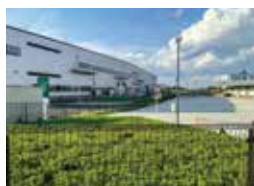
建設が進む物流団地
