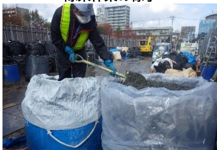
搬出作業の様子
