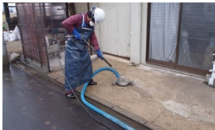
除染作業の様子
