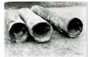
多田野水道木管
