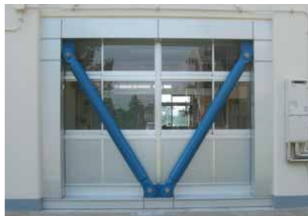
▼耐震化工事の例(建物)
