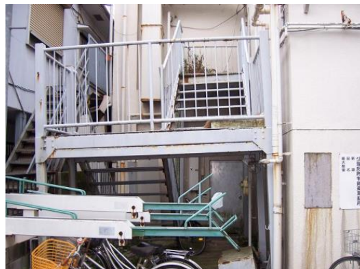
1－(2)－① 門、塀、屋外階段の傾斜 出典 国土交通省「特殊建築物等定期調査業務基準」
