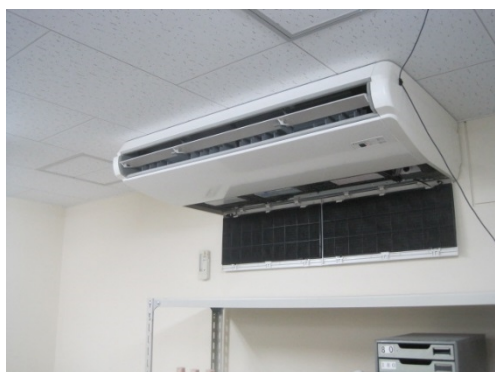
H1-1 エアコン室内機フィルターのホコリたまりの確認
