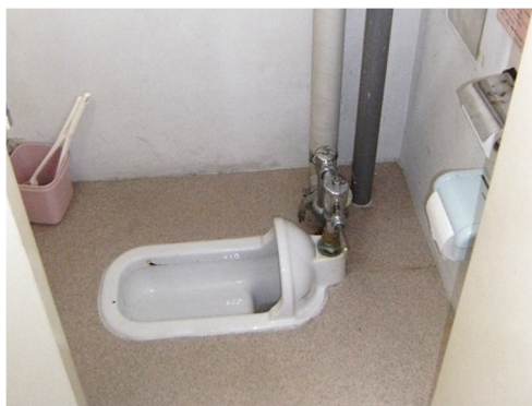
F 1 - 1 便器の破損、水漏れ等の確認
