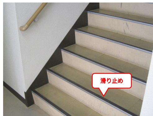
E 5-2 階段滑り止めの破損や剥がれの確認
