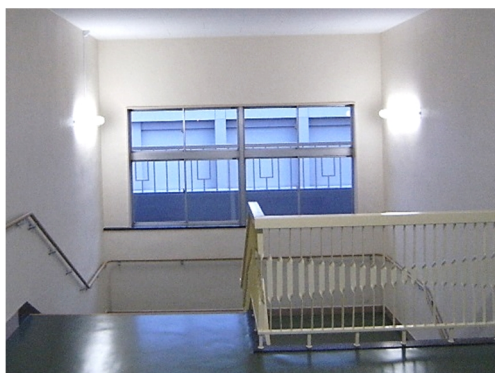
E 5-1 手すり・フェンスのぐらつきの確認
