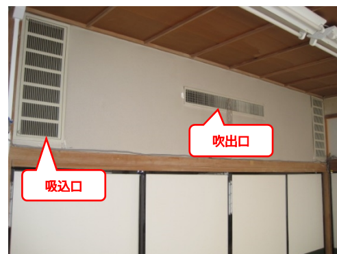
H2-2 空調機の吹出口、吸込口の ホコリたまりの確認
