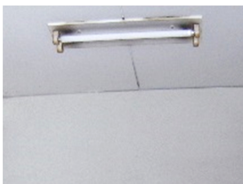
I 2 照明器具の点灯不良や異音の確認
