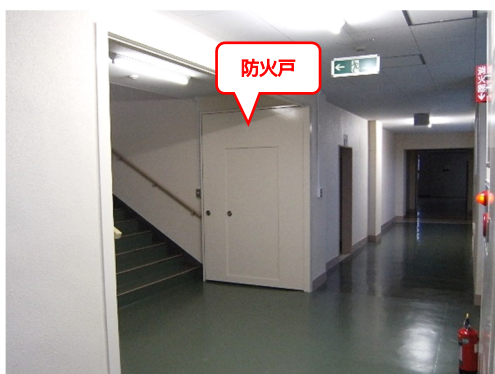
E 7 避難経路の障害物の確認
