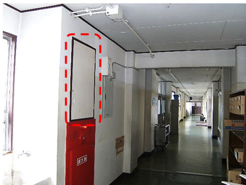
F 2 - 3 パイプシャフト扉 (この中に水道管などがあります)
