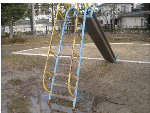
A 5-2 遊具の腐食、ぐらつきの確認
