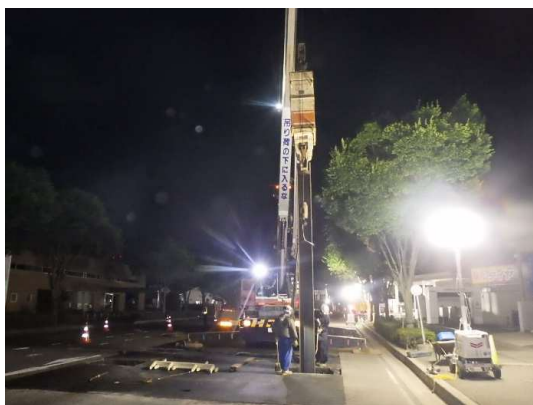
鋼矢板引抜き状況
