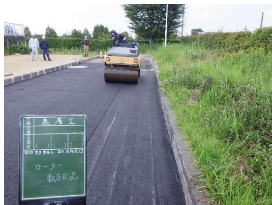
舗装仮復旧状況
