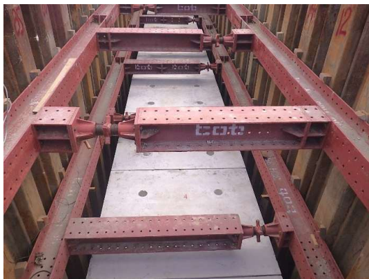
ボックスカルバート布設状況
