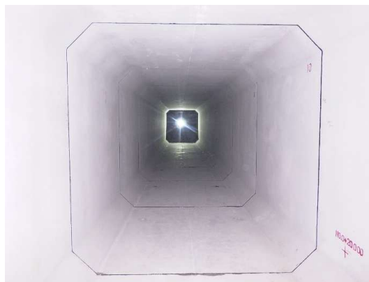
ボックスカルバート布設完了
