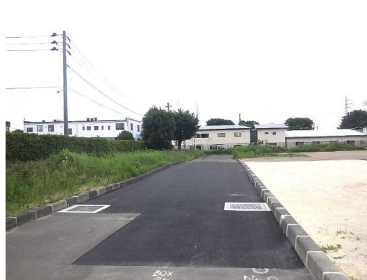
舗装仮復旧完了
