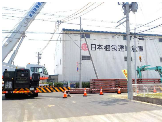
流入水路：覆工板設置状況
