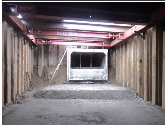
流入水路：基礎碎石完了
