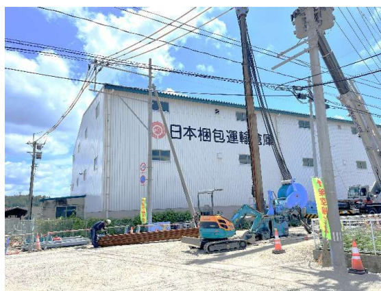
流入水路：鋼矢板設置状況
