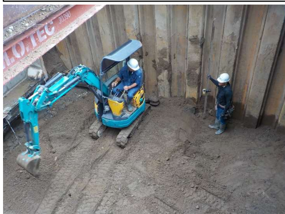
流入水路：掘削状況
