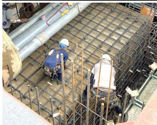
到達立坑 特殊人孔施工状況(鉄筋・型枠工)
