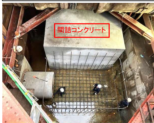
発進立坑 鉄筋工状況・間詰コンクリート打設完了
