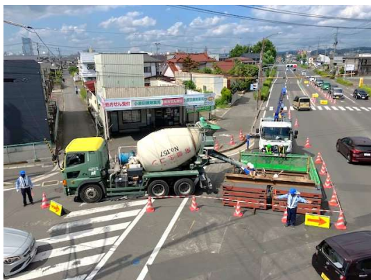
割込人孔 ライトプレート裏込状況
