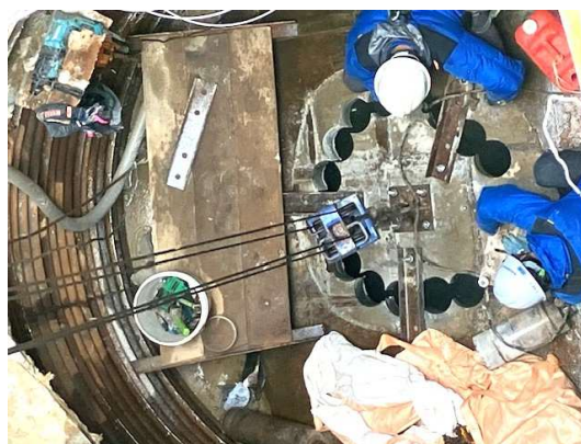
割込人孔補強工(作業孔削孔状況)
