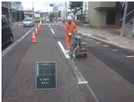
区画線工状況
