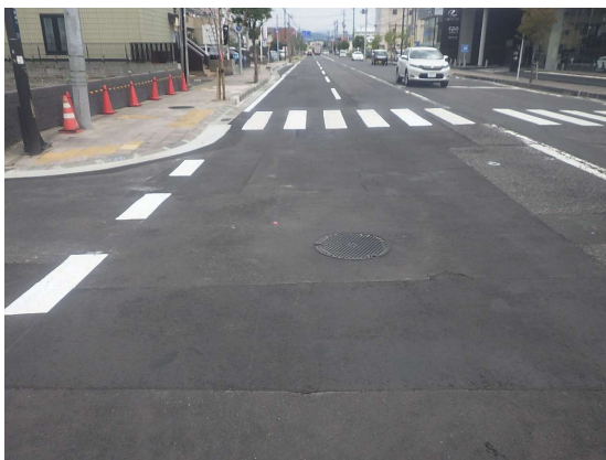
舖裝恢復舊完了
