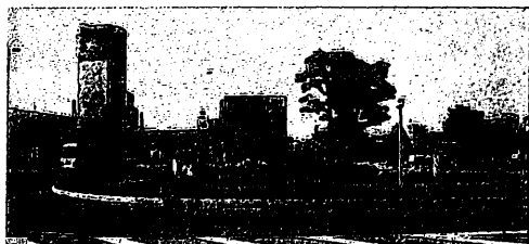
郡山駅東口広場
