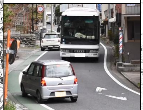
3-① 玉川村大字南須金地内 石川町大字母畑地内拡幅改良整備
