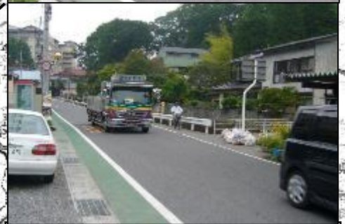
主要地方道 古殿須賀川線 (L≒3,300m)
