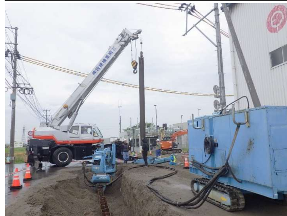
鋼矢板引抜き状況
