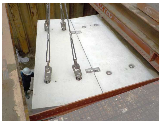
ボックスカルバート布設状況
