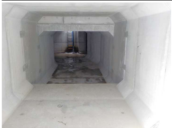
ボックスカルバート布設完了
