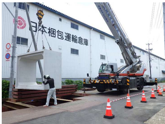
ボックスカルバート布設状況
