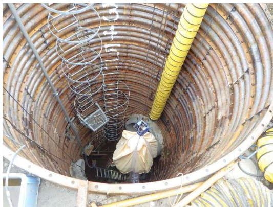
割込人孔 地上から貯留管内への作業状況
