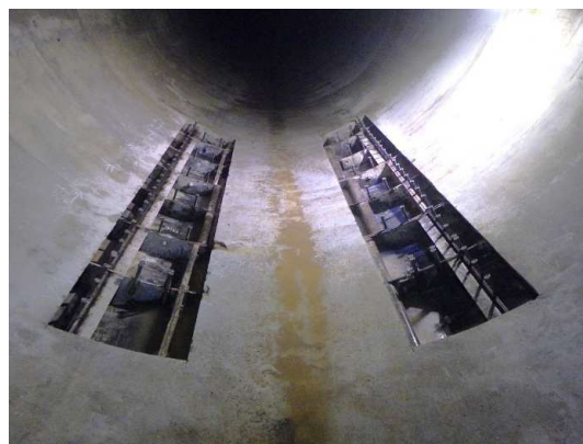
貯留管内 補強筋設置のための下部作業完了
