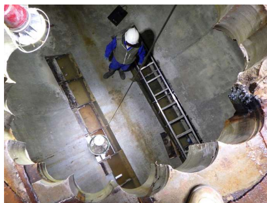
割込人孔 貯留管内の作業状況
