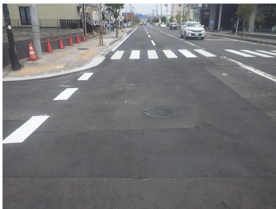
舗装仮復旧完了（上流から下流を望む）
