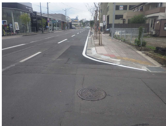
舗装仮復旧完了（下流から上流を望む）
