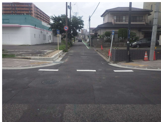
舗装仮復旧完了（上流から北側を望む）
