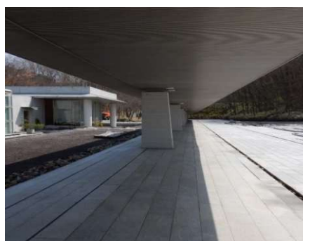
キャノピー下の地盤沈下による床面の歪み
