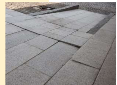
キャノピー下の地盤沈下による床面の歪み
