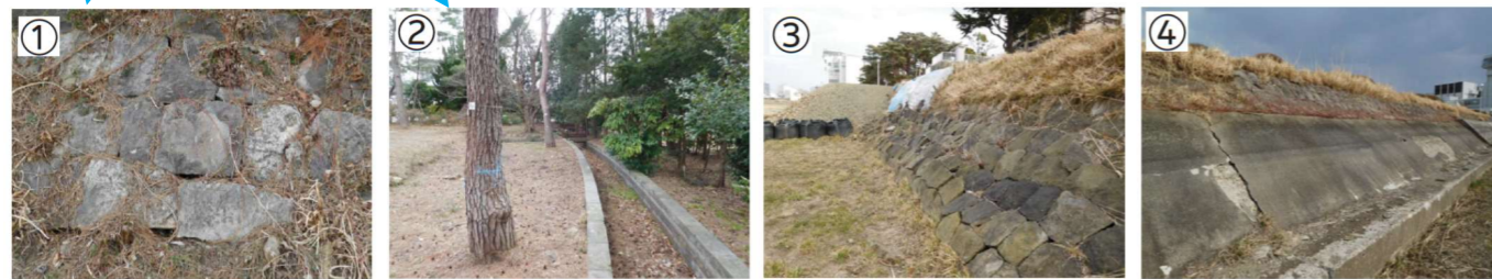
① 貯水池内面石張 明治44年(1911年)近代水道創設時に内面補強 ② 安積疏水流入水路 明治44年に安積疏水の水を貯水池に引込むために設置した煉瓦造りの水路 ③ 石張のみ(コンクリート補強無し) 貯水池の南側は築堤ではないため、コンクリート補強がない。 ④ 石張及びコンクリート補強 貯水池を安定的に維持管理するため築堤部をコンクリートで補強
