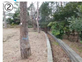
② 安積疏水流入水路 明治44年に安積疏水の水を貯水池に引込むために設置した煉瓦造りの水路
