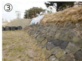
③ 石張のみ(コンクリート補強無し) 貯水池の南側は築堤ではないため、コンクリート補強がない。
