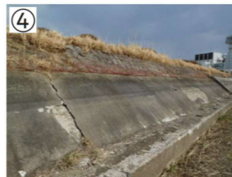
④ 石張及びコンクリート補強 貯水池を安定的に維持管理するため築堤部をコンクリートで補強
