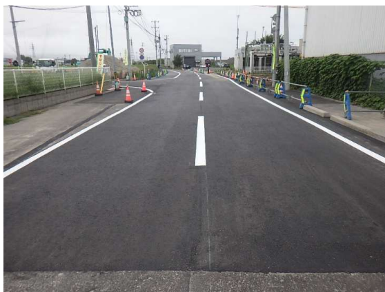
合流桝流入水路部 舗装仮復旧完了
