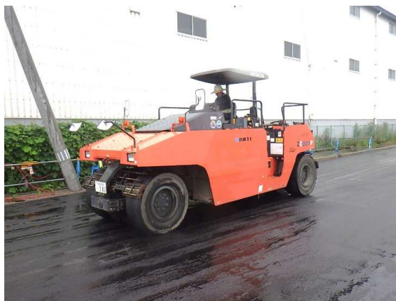
合流桝流入水路部 舗装仮復旧状況
