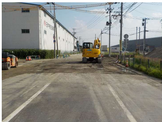
合流桝流入水路部 路盤復旧状況
