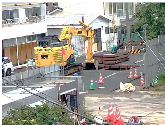
発進立坑 作業状況
