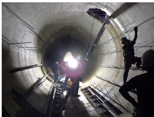
貯留管内 補強筋設置作業状況
