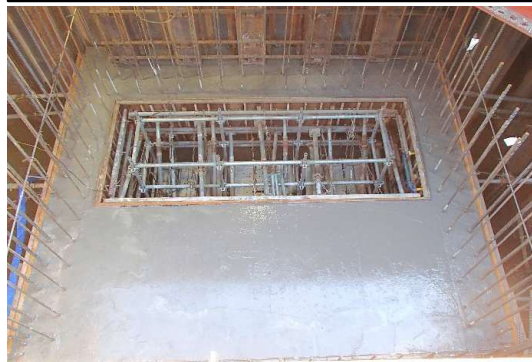
割込人孔・貯留管との接続管 (内面施工完了)
