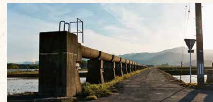
三穂田の水路橋 Mihota Aqueduct
