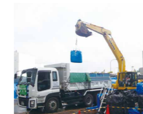
▲除去土壌等の掘り起こしと中間貯蔵施設への輸送
