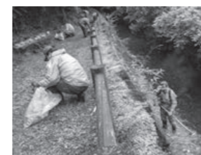
▲草刈り機が届かないところは手作業で丁寧に清掃する
