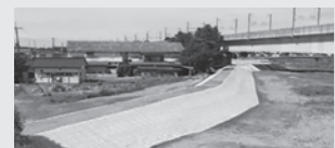
阿武隈川御代田地区堤防整備(国土交通省)(今年7月)
