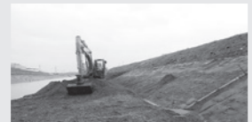
谷田川河道掘削(福島県)(今年4月)
