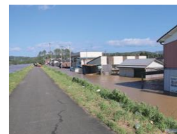
▲水門町の被害(左が堤防) ※行合橋から北をのぞむ
