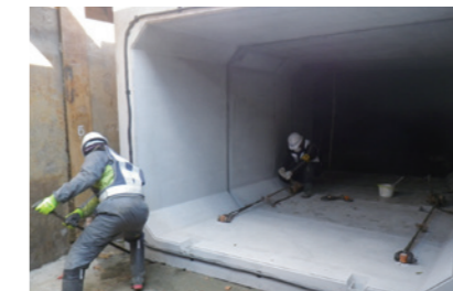
▲整備中の133号雨水幹線(中央工業団地)
