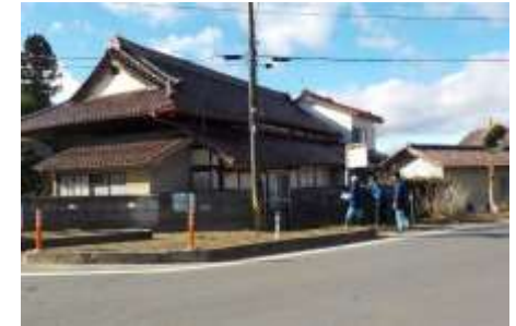
損壊家屋の建物調査 (田村町下行合)
