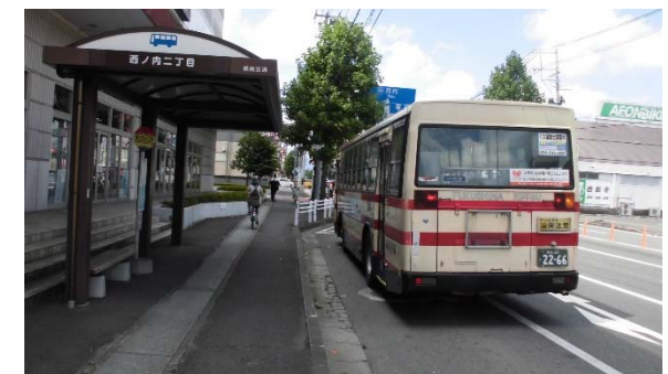
整備済みのバスベイ（西ノ内二丁目）
