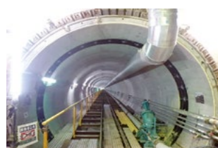
▲図景貯留管築造工事
