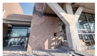
▲公共施設などの応急修理
