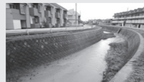
▲準用河川照内川河道掘削
