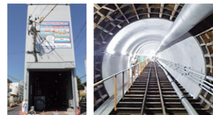
雨水貯留管(図景地区)の整備
