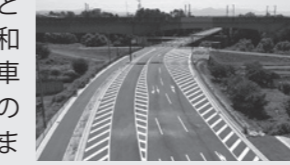
▲笹川大善寺線全線供用集積が進む大町大槻線の道路改良工事
