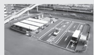
▲同駅西口広場改良工事
