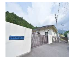
安積疏水発電所
