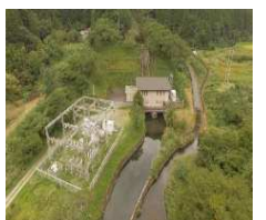
竹之内発電所
