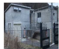
水道山水力発電所
