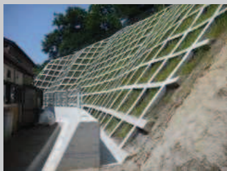
[対策例] 法枠工
