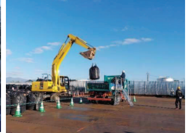
積込場での除去土壌の搬入作業
