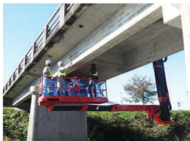
橋りょう点検の様子
