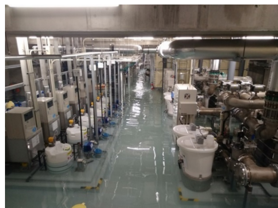
水没した地下1階ろ過機械室
