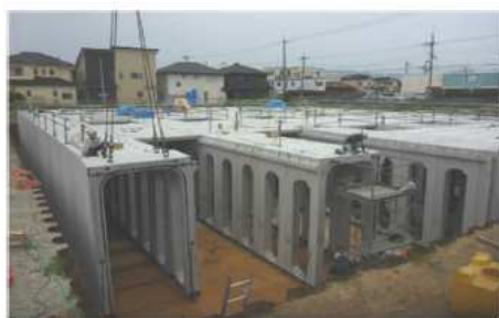
貯留槽（地下に施工）
