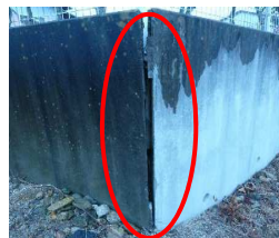
○田村保育所 土留め擁壁修繕
