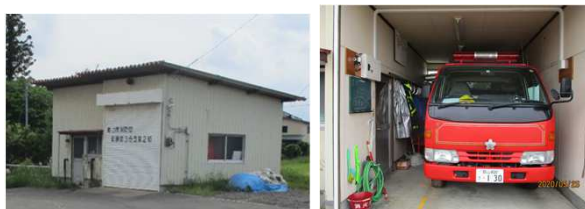
【現在の車庫詰所（築後約40年経過）】
