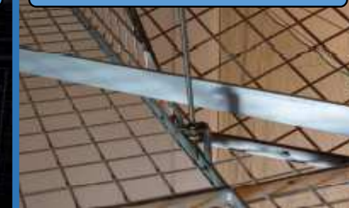
吊り天井修繕
