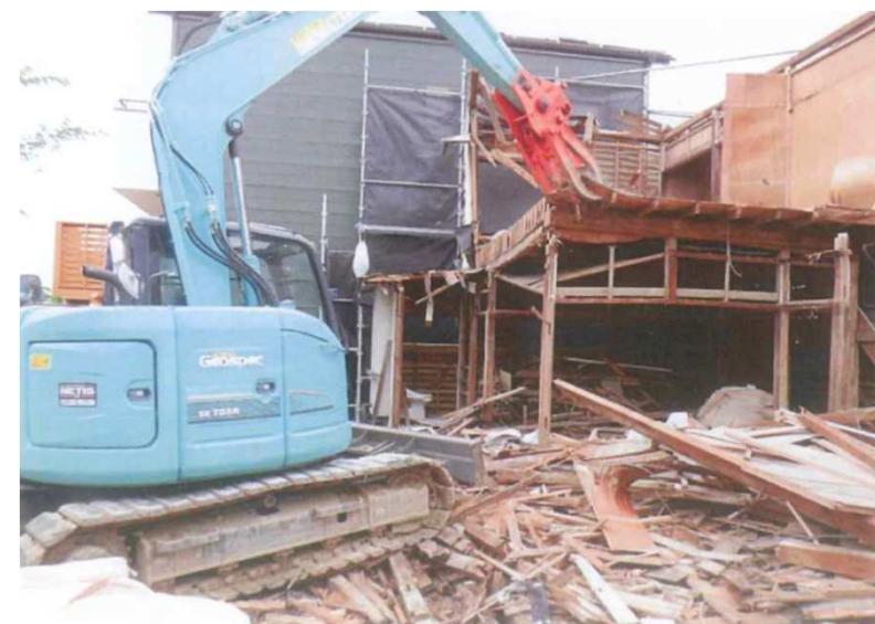
被災した家屋の解体作業の様子
