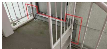
○中野保育所 外階段修繕
