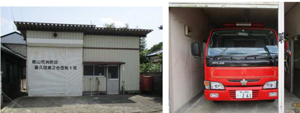
【現在の車庫詰所（築後約40年経過）】
