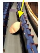
空調吹出口落下
