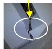
天井一部破損
