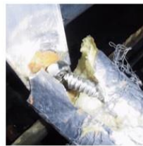
空調機冷温水配管破損
