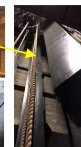
吊り物レール等破損
