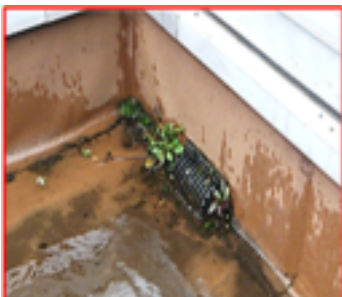
カルチャーセンター陸屋根
