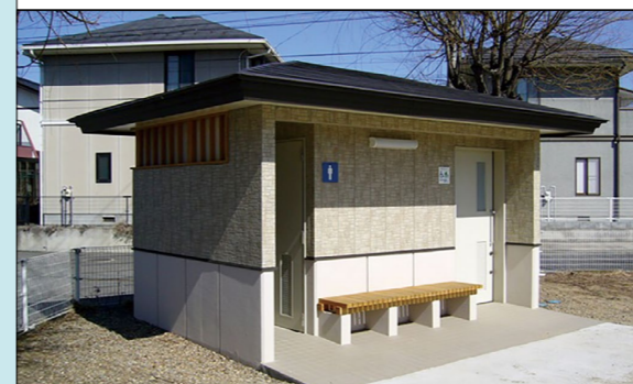
UD化されたトイレ
