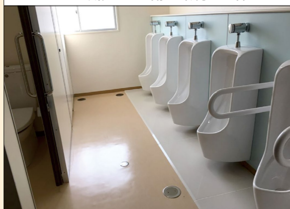
トイレ改修による衛生環境の確保
