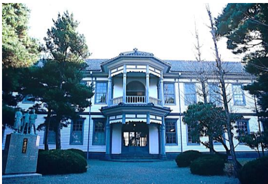
33 旧福島県尋常中学校本館
