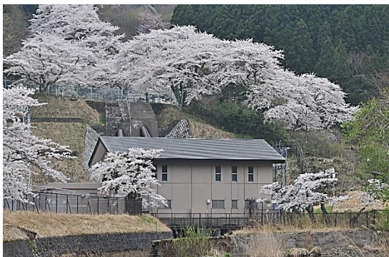
31 竹之内発電所
