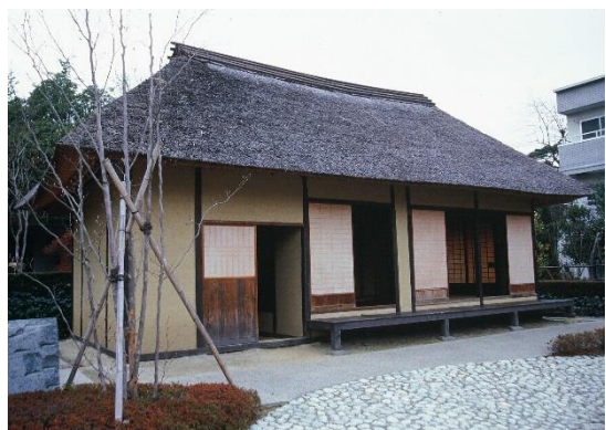
18 安積開拓入植者住宅－旧小山家
